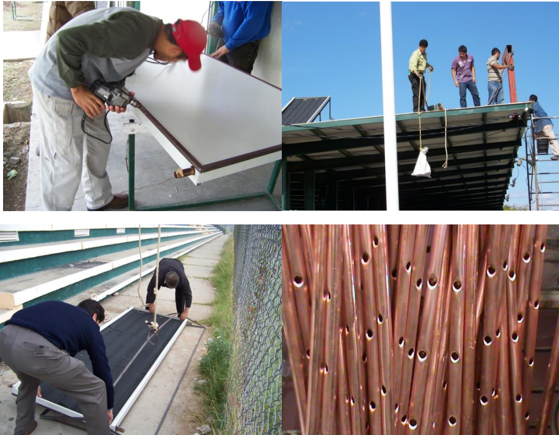
Figura 13.2 Proceso de implementación del colector solar
